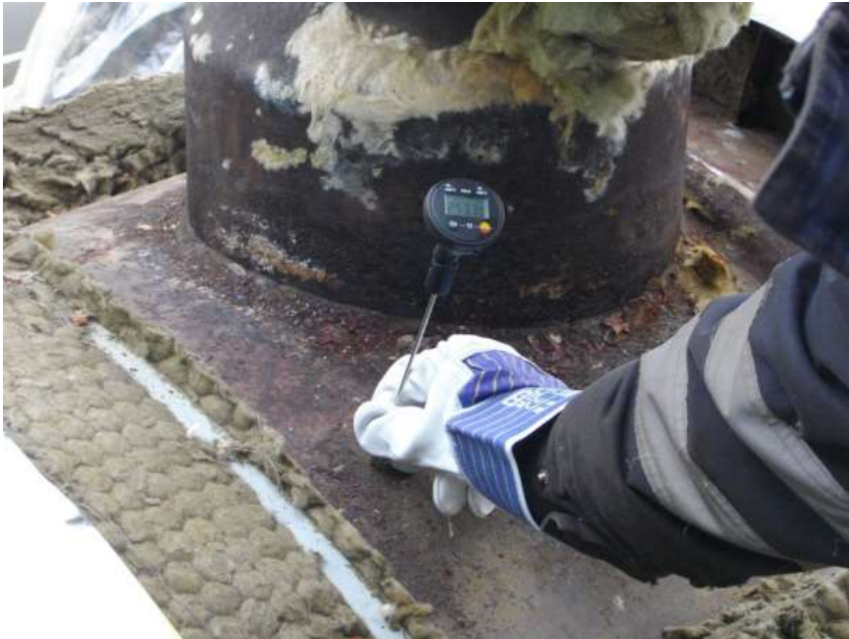
Heißprüfung an einem Wärmeaustauscher der Entschwefelungsanlage
